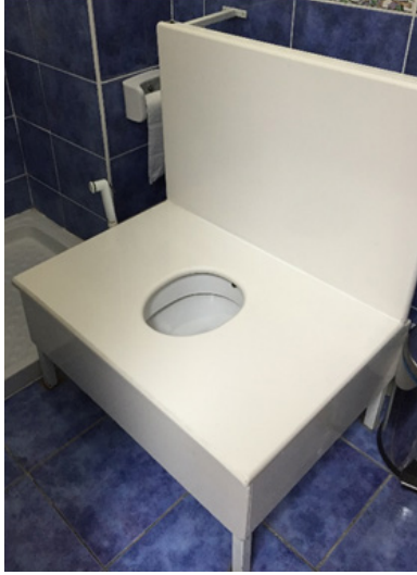
Şekil 5. Obez hastaların oturup kalkmalarını kolaylaştıran özel üretim klozet
